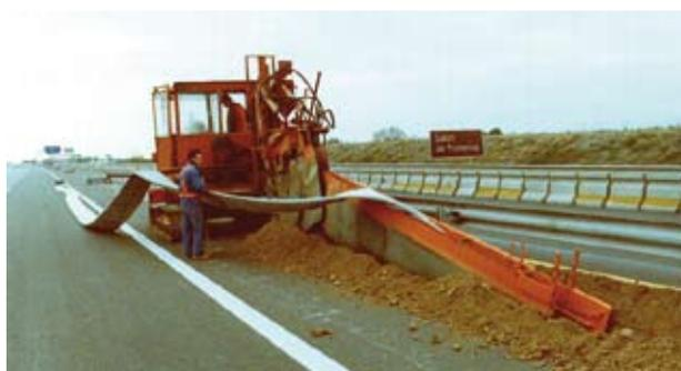
Au cours des 10 dernières années, une nouvelle sorte de matériau de drainage est apparue sur le marché des géosynthétiques et acquiert actuellement une rapide reconnaissance dans la construction et l'industrie du BTP : les composites de drainage.
