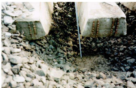
Figures 3 et 4 : Extraction du géotextile
