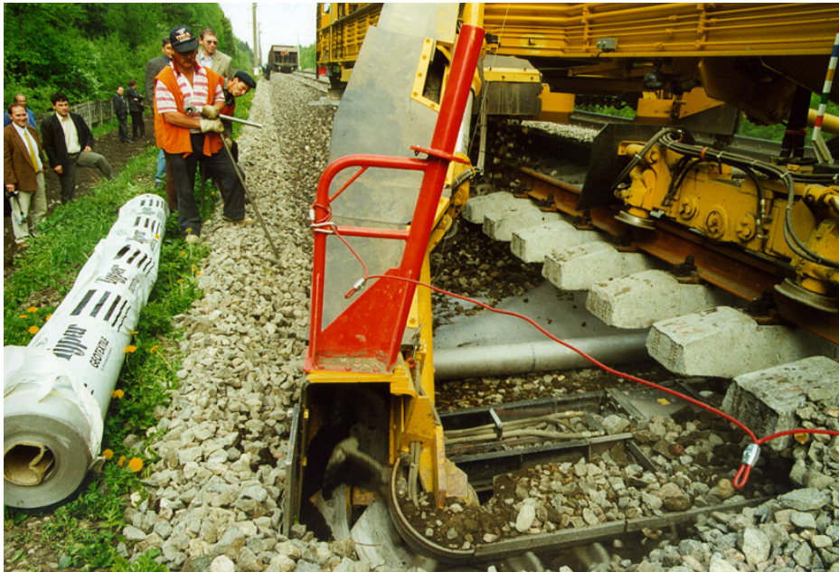
Figure 2 : Processus de rénovation de la ligne automatisé
