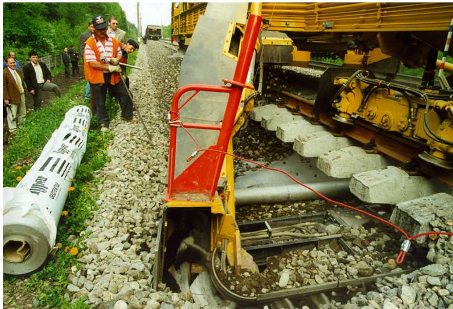
Figure 2 : Processus de rénovation de la ligne automatisé
