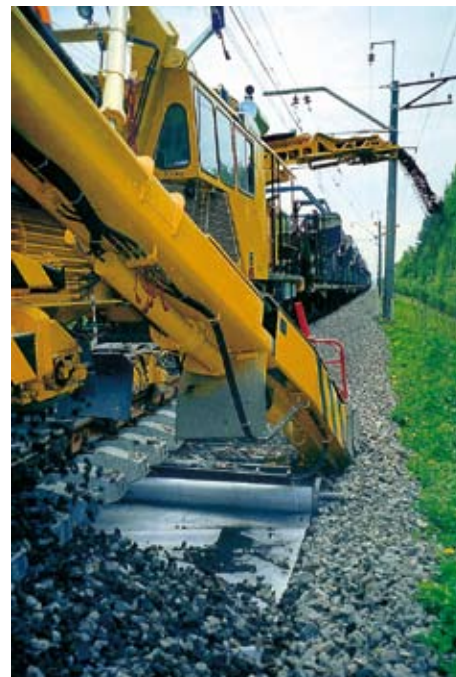
Förnyelse av järnvägsspår mellan Moskva och St Petersburg, Ryssland
