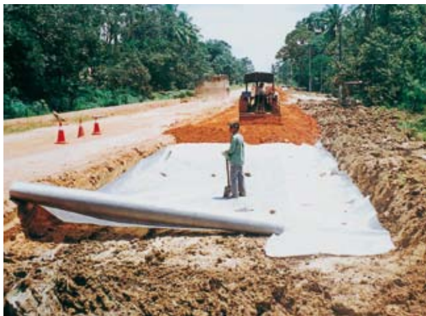
Construcție de drum, Malaezia
